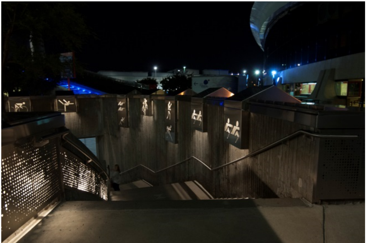
Photo -3 - Place Nadia Comenaci : l'escalier vers la cour inférieure
